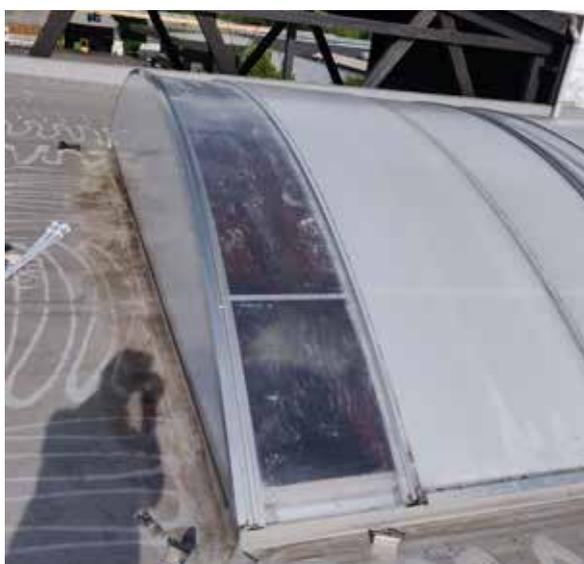
Les exigences à la résistance au feu auxquelles un toit plat doit répondre sont très sévères. Dans le cas d'une voûte filante, l'obtention de la classe de résistance au feu  $B_{ROOF}(t1)$  s'avère très difficile.
